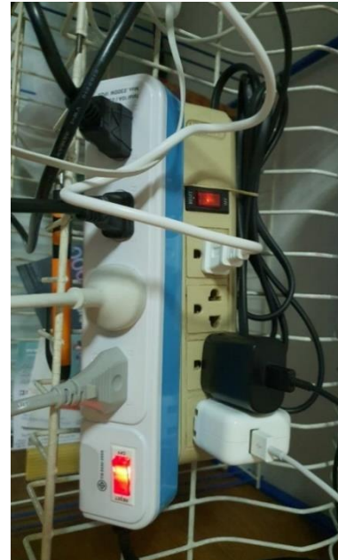
รูปที่ 5 ตัวอย่างการใช้งานเครื่องใช้ไฟฟ้าพร้อมกันจำนวนมากในปลั๊กพ่วงแต่ละตัว และการใช้ปลั๊กพ่วงต่อกันเป็นทอด ๆ (ปลั๊กพ่วง ต่อปลั๊กพ่วง) ซึ่งอาจทำให้กำลังไฟรวมเกินขนาดที่ปลั๊กพ่วงสามารถรองรับได้ อาจก่อให้เกิดกระแสไฟฟ้าลัดวงจรและส่งผลให้เกิดเพลิงไหม้ได้
