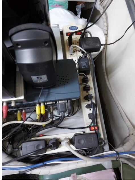
รูปที่ 5 ตัวอย่างการใช้งานเครื่องใช้ไฟฟ้าพร้อมกันจำนวนมากในปลั๊กพ่วงแต่ละตัว และการใช้ปลั๊กพ่วงต่อกันเป็นทอด ๆ (ปลั๊กพ่วง ต่อปลั๊กพ่วง) ซึ่งอาจทำให้กำลังไฟรวมเกินขนาดที่ปลั๊กพ่วงสามารถรองรับได้ อาจก่อให้เกิดกระแสไฟฟ้าลัดวงจรและส่งผลให้เกิดเพลิงไหม้ได้
